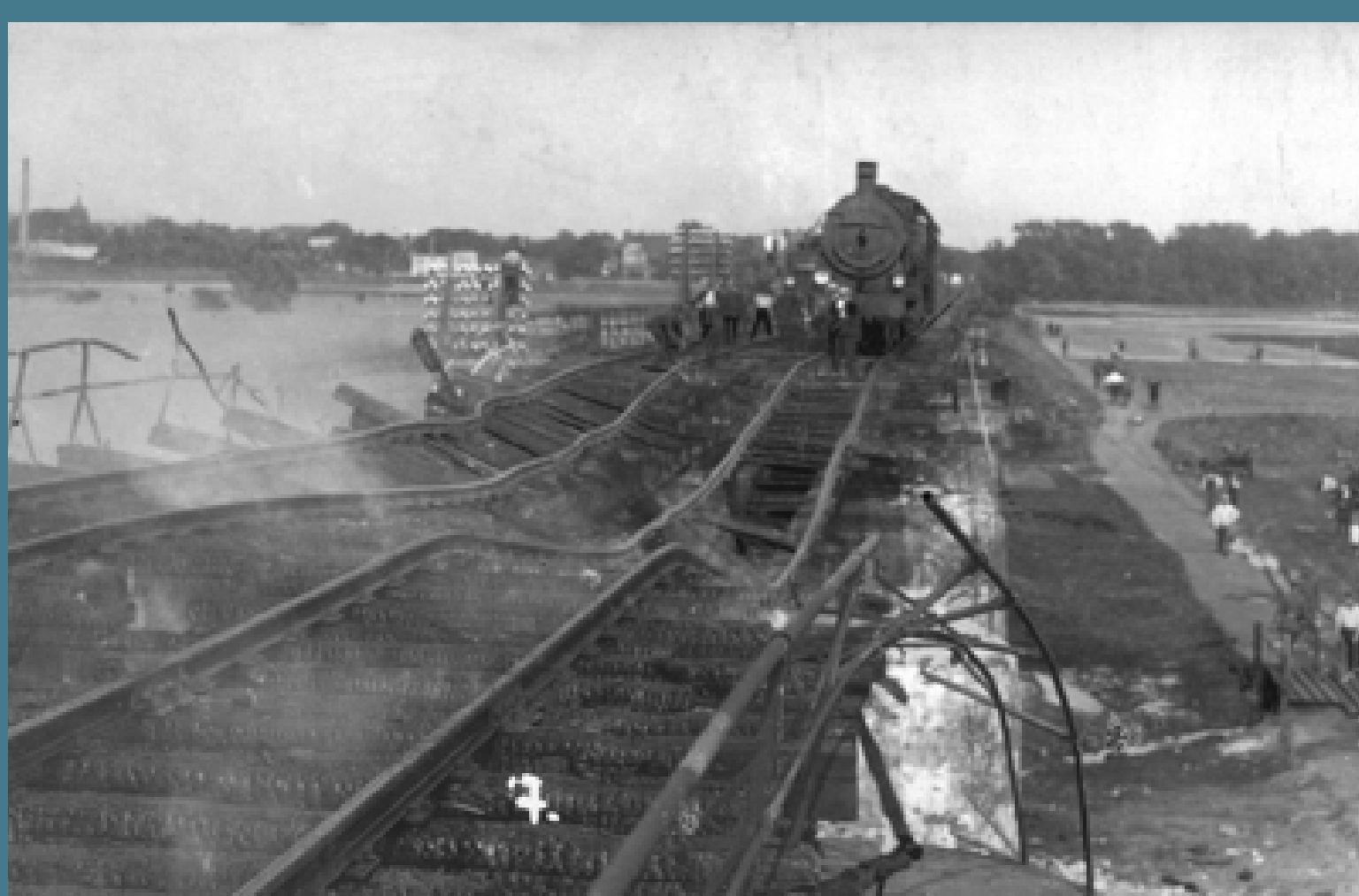
Most kolejowy w Opolu-Szczepanowicach zniszczony w nocy z 2 na 3 maja 1921 r. przed oddział por. Lucja Miładowskiego z grupy destrukcyjnej „Wawelberga”, autor nieznany, fot. ze zbiorów Muzeum Czynu Powstańczego – oddziału Muzeum Śląska Opolskiego
